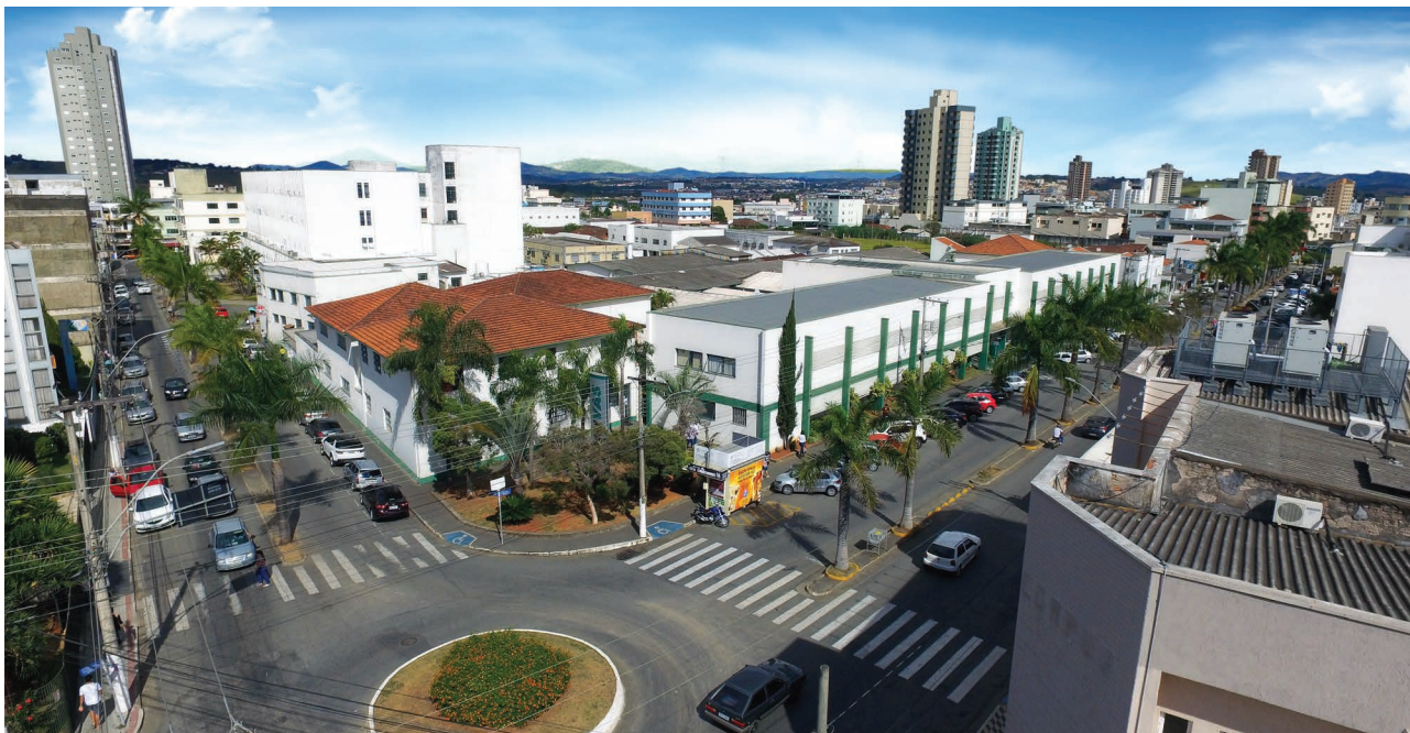
Vista aérea da Unidade Central, 2018
