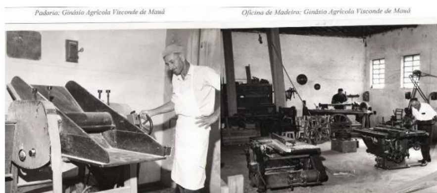
Figura 14 – Padaria e oficina de madeira Fonte: arquivo de particular
